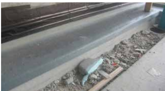
Damp en luchtdicht afgeplakt tegen het binnenblad
